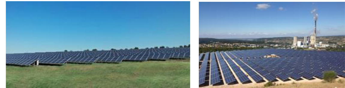
Figure 16 : Réalisations d'URBASOLAR : à gauche, Granitec en Bulagrie ; à droite, aménagement d'un ancien terroir à Gardanne (13) (Crédit photo : URBASOLAR)
