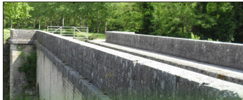
Figure 39 : Pont-canal sur la Sauldre (Crédit photo : mairie de Châtillon-sur-Cher)
