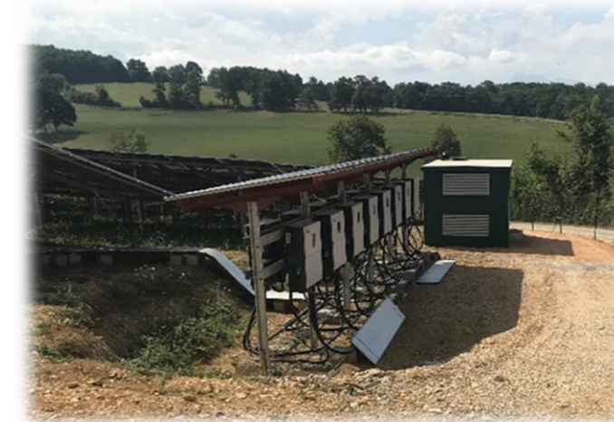
Figure 31: Exemple d'auvents-onduleurs (Source : URBA 282)
