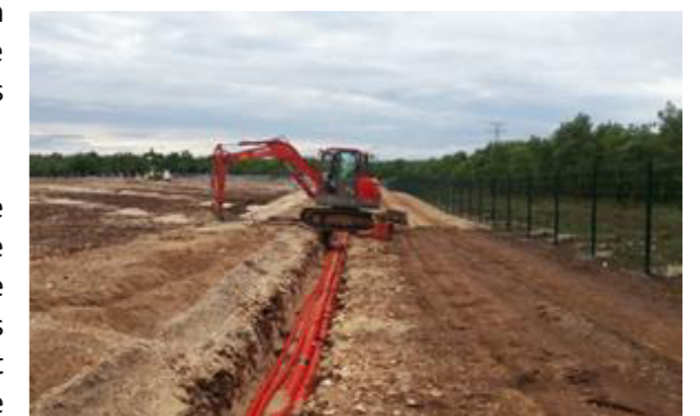
Figure 28 : Mise en place des tranchées de câbles électriques (Source : URBA 282)
