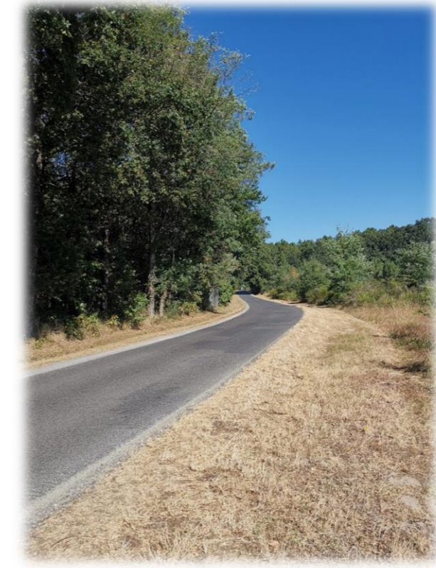
Vue D' : Vue depuis le bord de route au sud-ouest du site en direction du nord, nord-ouest.
