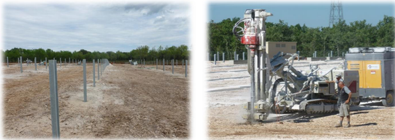
Figure 29 : Illustrations de la pose des structures porteuses (Source : URBA 282)
